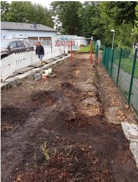
Die Umbaumaßnahme ist in vollem Gange.
